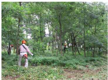
↑D地区 作業開始時の状況
