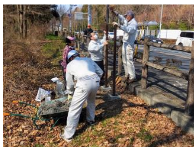
看板設置用支柱埋め込み
