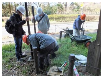
看板設置用支柱埋め込み
