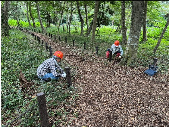
E地区散策路作業中
