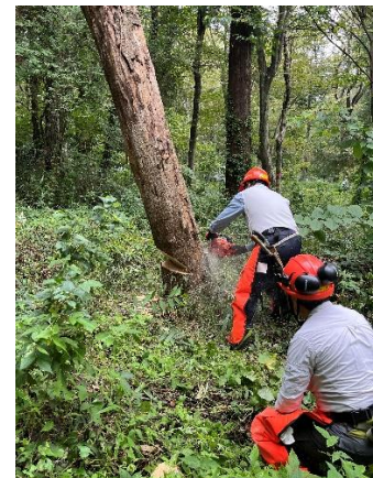
A地区枯損木の伐木作業
