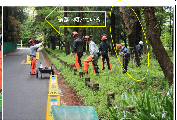
道路沿いの危険木と作業前ミーティング
