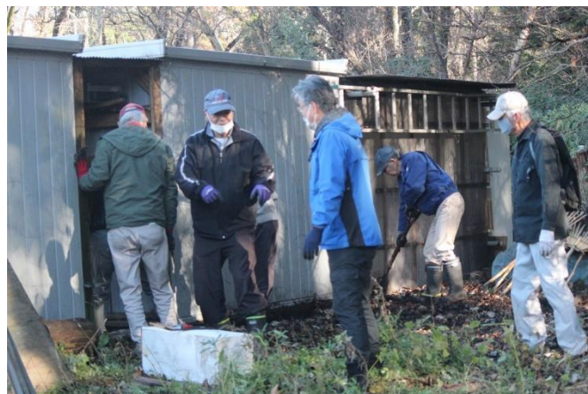
腐食した倉庫間の扉を修繕する
