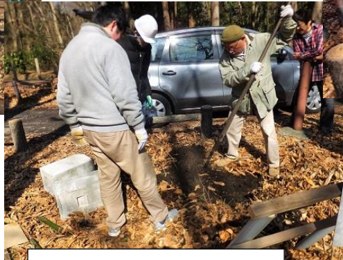
基礎ブロック埋め込み作業中
