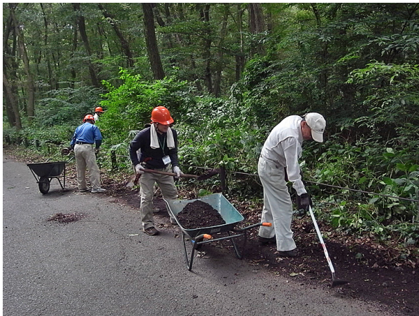
堆積土砂の撤去
